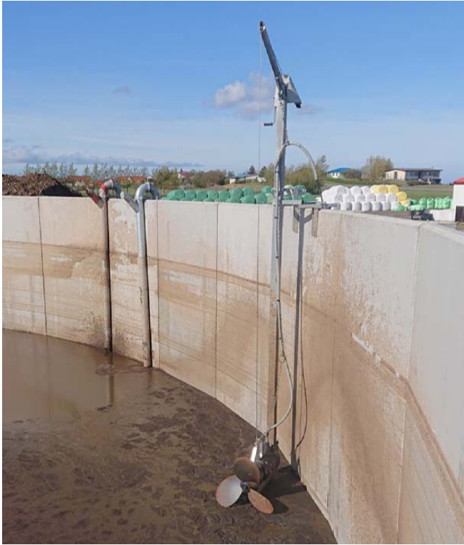
Mynd 2. Séð ofan í tankinn, frá vinstri má fyrst telja áfyllingarrörið, svo tæmingarrör og næst myndavélinni er 18,5 kw haugskrúfa sem snýst um 1.500 snúninga á mínútu á fullum afköstum.
