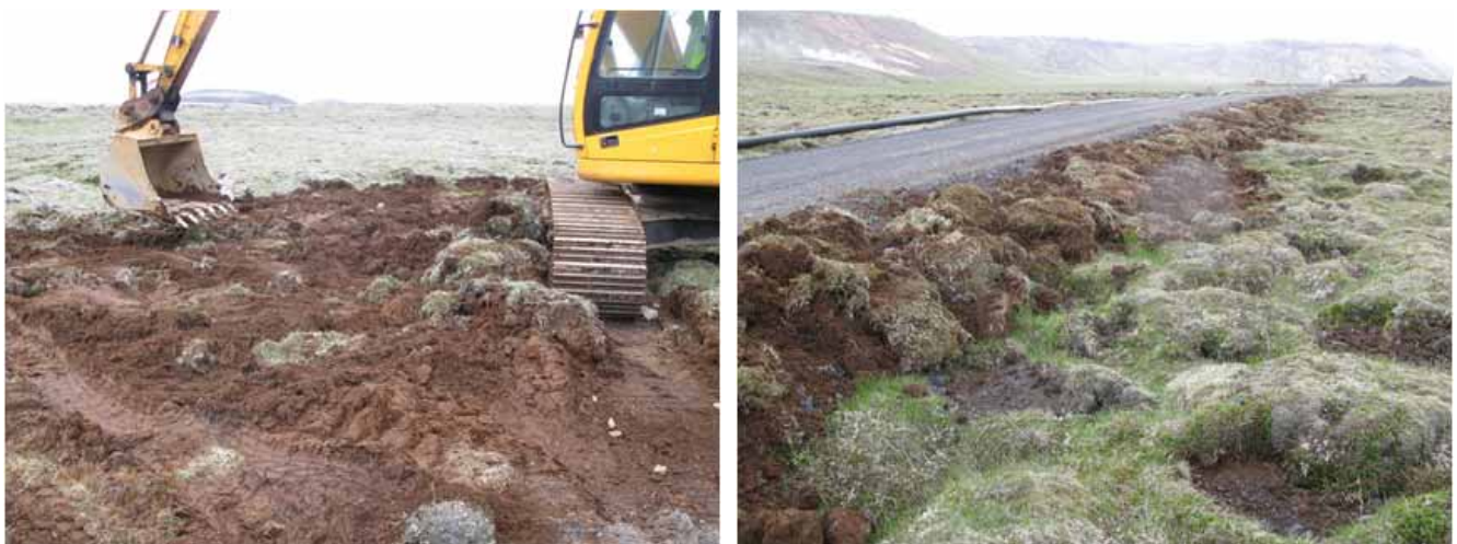
Mynd 4.2. Gróðursvörður tekinn upp af borplani 36 og lagður í vegfláa við Hverarhlíðarveg. Myndirnar eru teknar 21. og 22. júní 2007.
