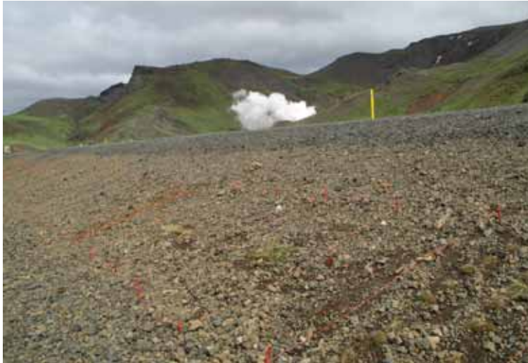
Mynd 3.23. Vegfláatilaun með graslendistorfum (GV) í júní 2007.
