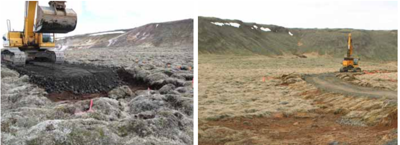
Mynd 4.1. Gróðursvörður tekin úr vegstæði Hverahlíðarvegar og lagður jafnóðum í vegfláann. Myndirnar eru teknar 9. og 11. maí 2007.
