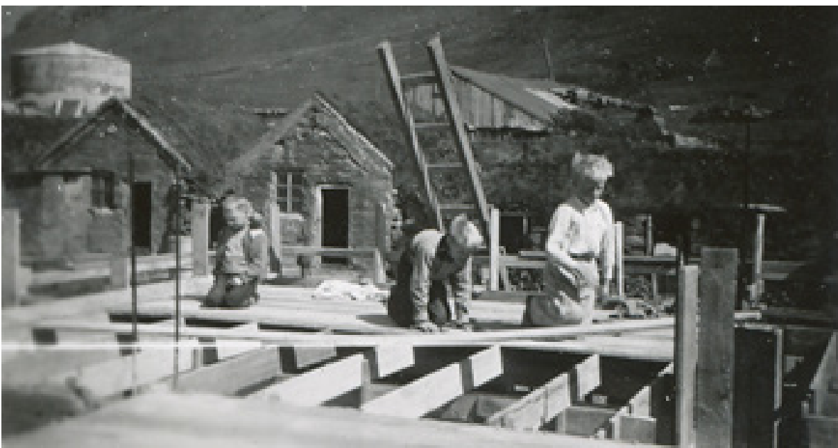
9. mynd. Fjós (7 og 10) og hlaða (8). Nýi Miðbærinn í smíðum.
