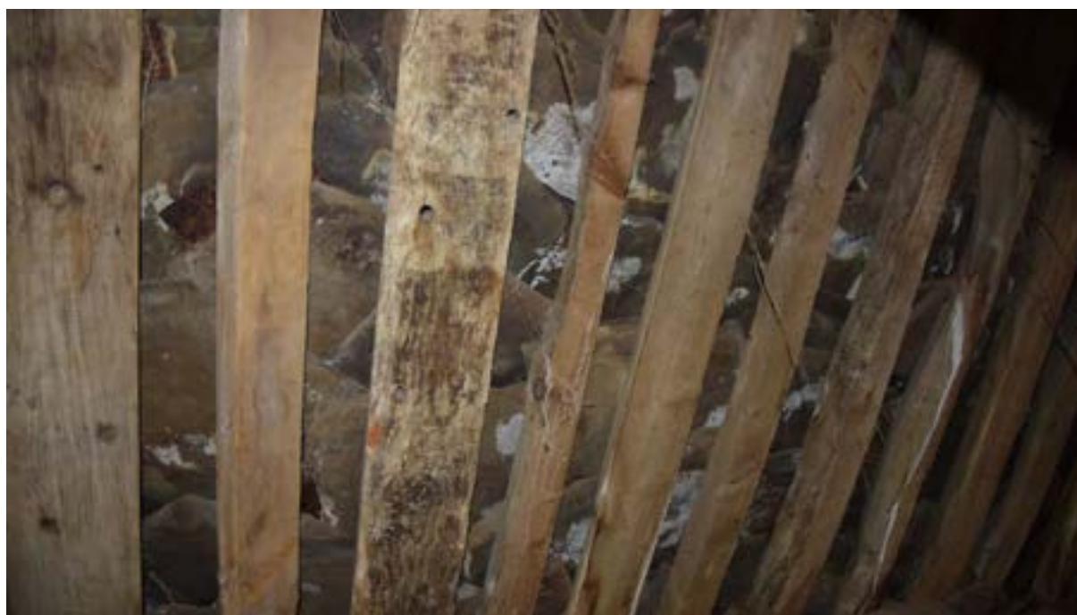
21. mynd. Þakið á vestra fjárhúsinu í Miðbænum séð innan frá, grjóthellan hvílir á röftunum og torfið er ofan á grjóthellunni.
