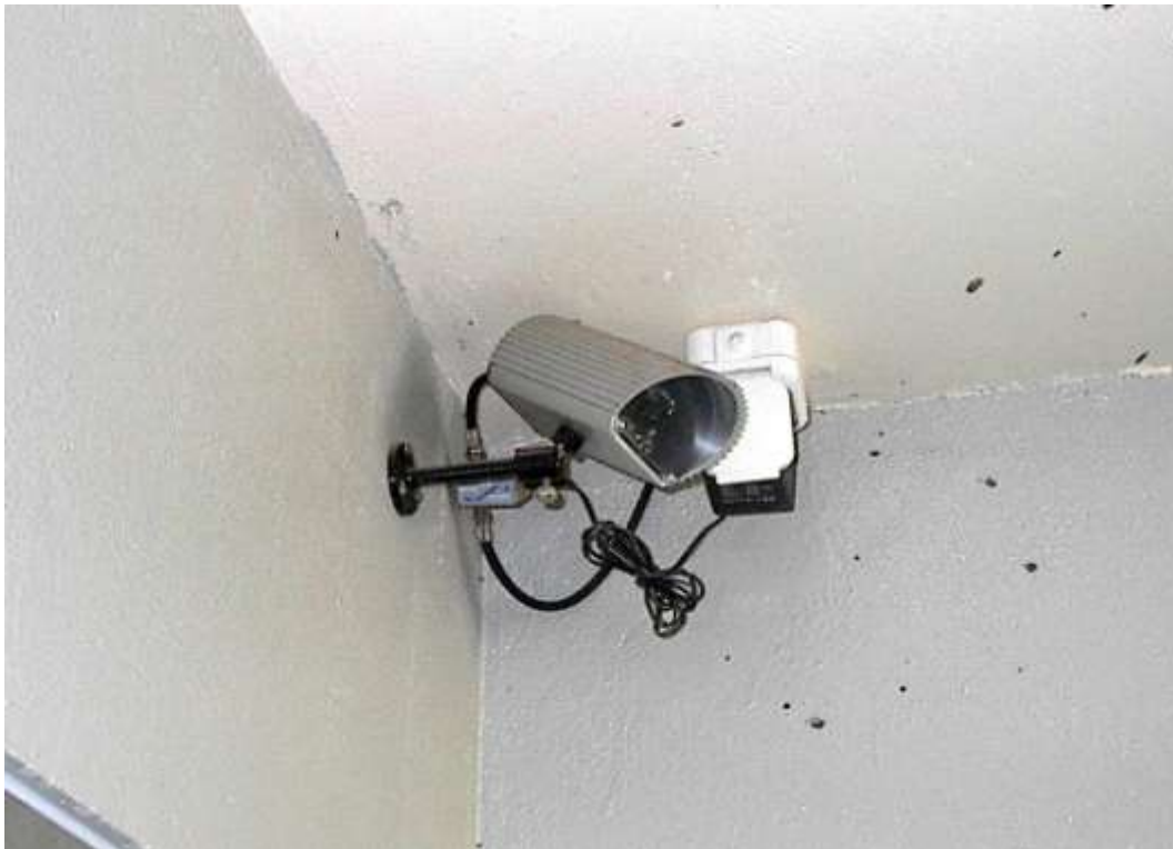
Hér er sjónvarpsmyndavél, sem sendir merki um snúru beint inn í íbúðarhús.
