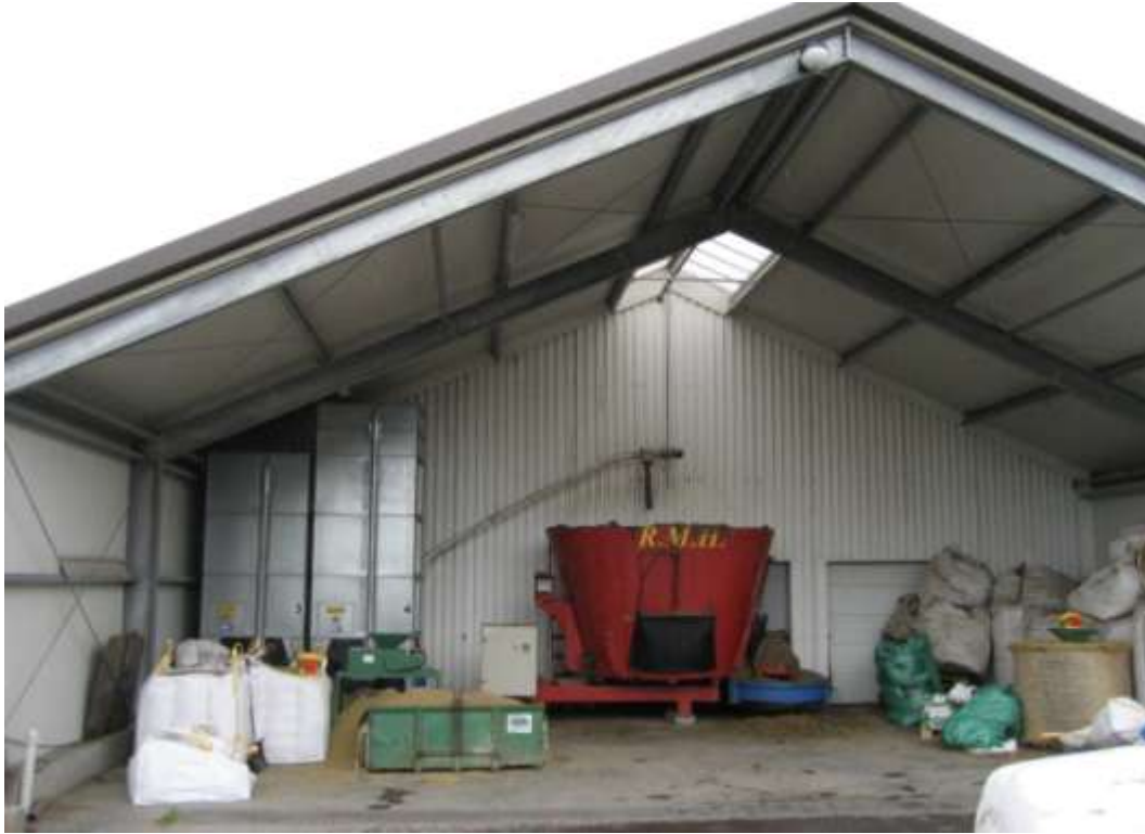
Afar áhugaverð lausn, hálfþak sem myndar fýðuraðstöðu í fjósi með keðjufýðurgang.
