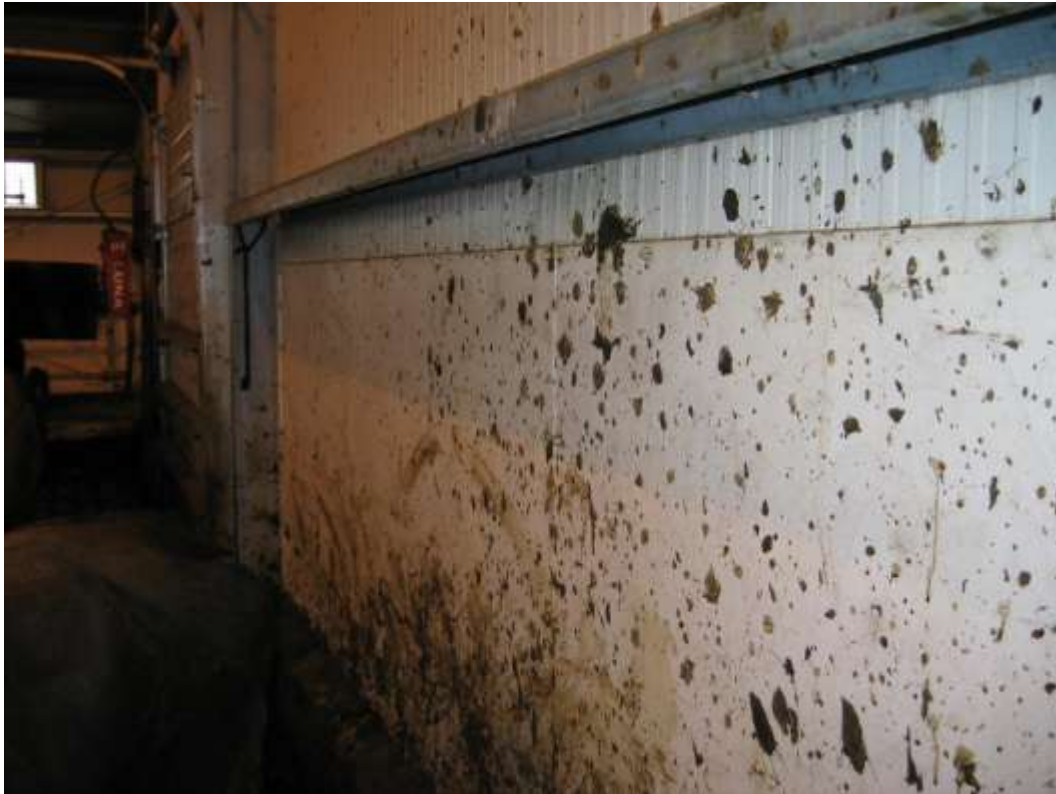
Í þessu fjósi voru boltaðar plötur utan á samlokueiningarnar.
