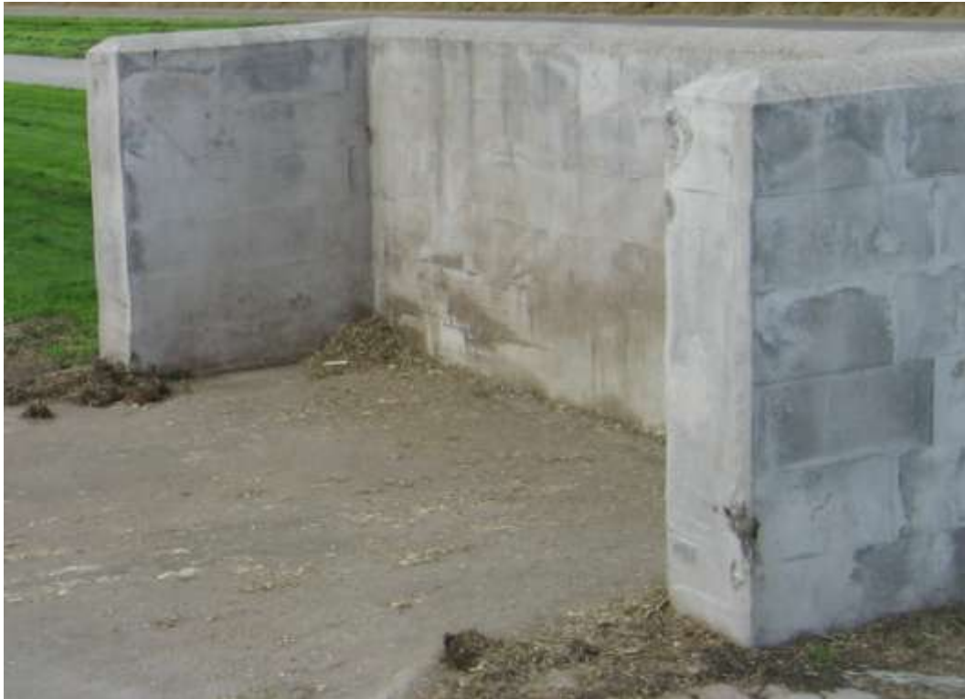
Oft er vinnuaðstaða við möð misgóð. Hér voru sérstaklega steyptir upp veggir sem möði var ýtt að og þaðan mokað og á vagn. Myndin er tekin erlendis.
