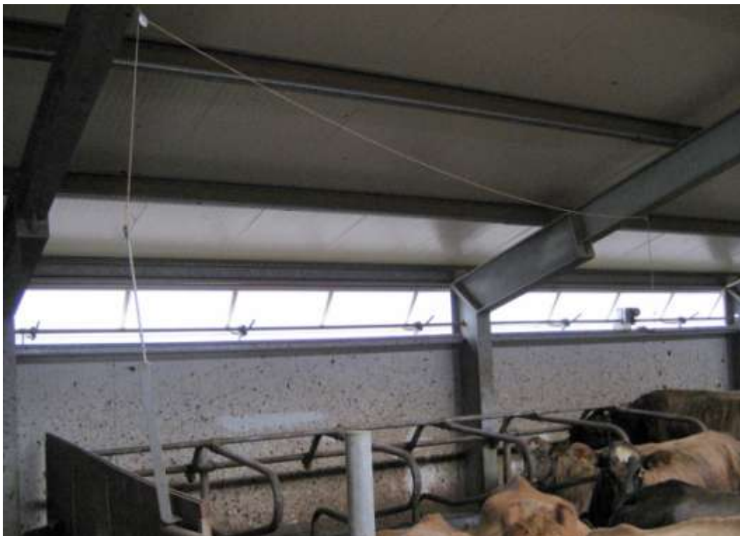
Hér má sjá einstaka hönnun og einfalda. Þegar reka þarf gripi á milli svæða innan fjóss lenda bændur oft í vanda við að opna hlið séu þeir einir að verki, eins og oftast er nú til dags. Þessi bóndi hafði útbúið sér vinnuléttandi tækni sem samanstendur af hliðlæsingarpinna (til vinstri) og spotta í tveimur trissuhjólum. Þegar hann rekur kú að hliðinu, togar hann í spottann og hliðið opnast!
