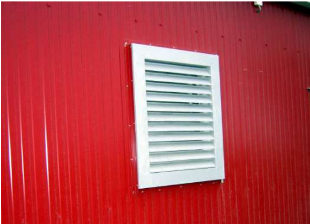
Þetta fjós var einnig með góða útloftunarrist á tækjarými.
