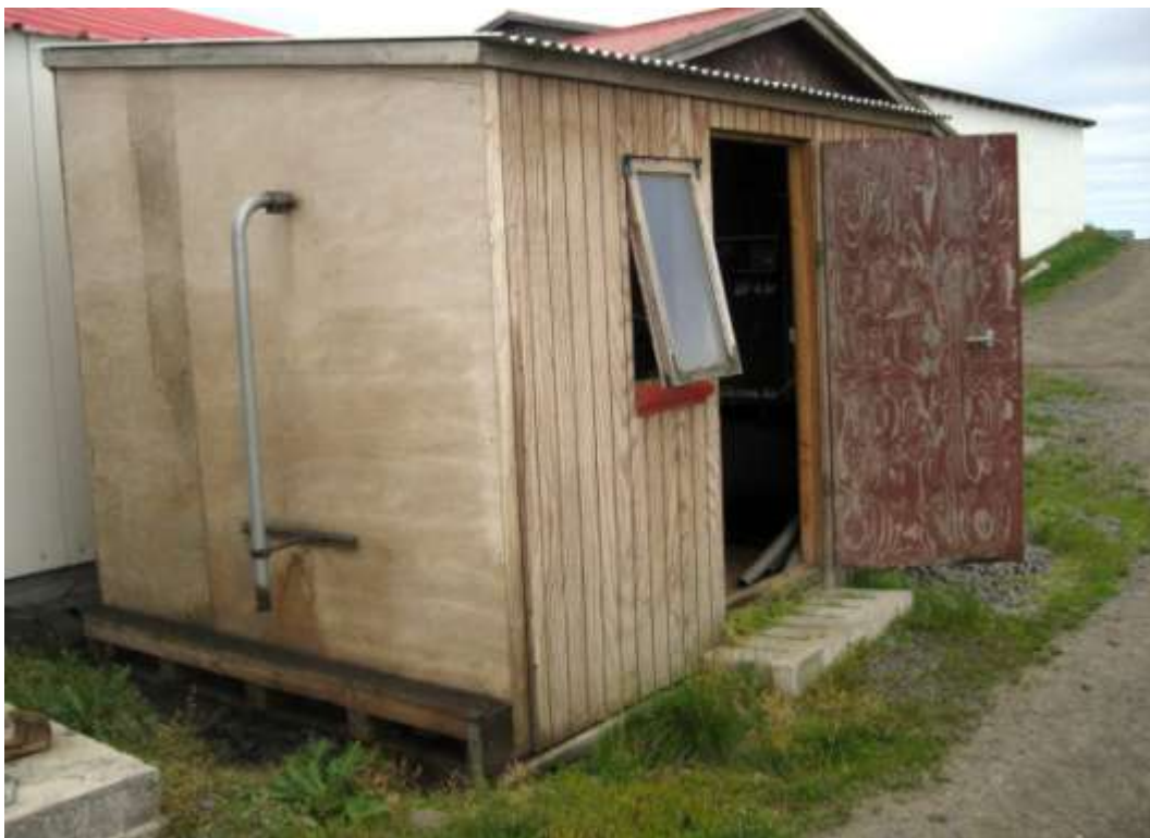
Engin raunveruleg ástæða er til þess að tækjarýmið þurfi að vera innan fjóss, hér var tækjunum komið fyrir í skúr utan við fjósvegg en reyndar ekki með loftræstingu eins og sjá má á aðkomunni.
