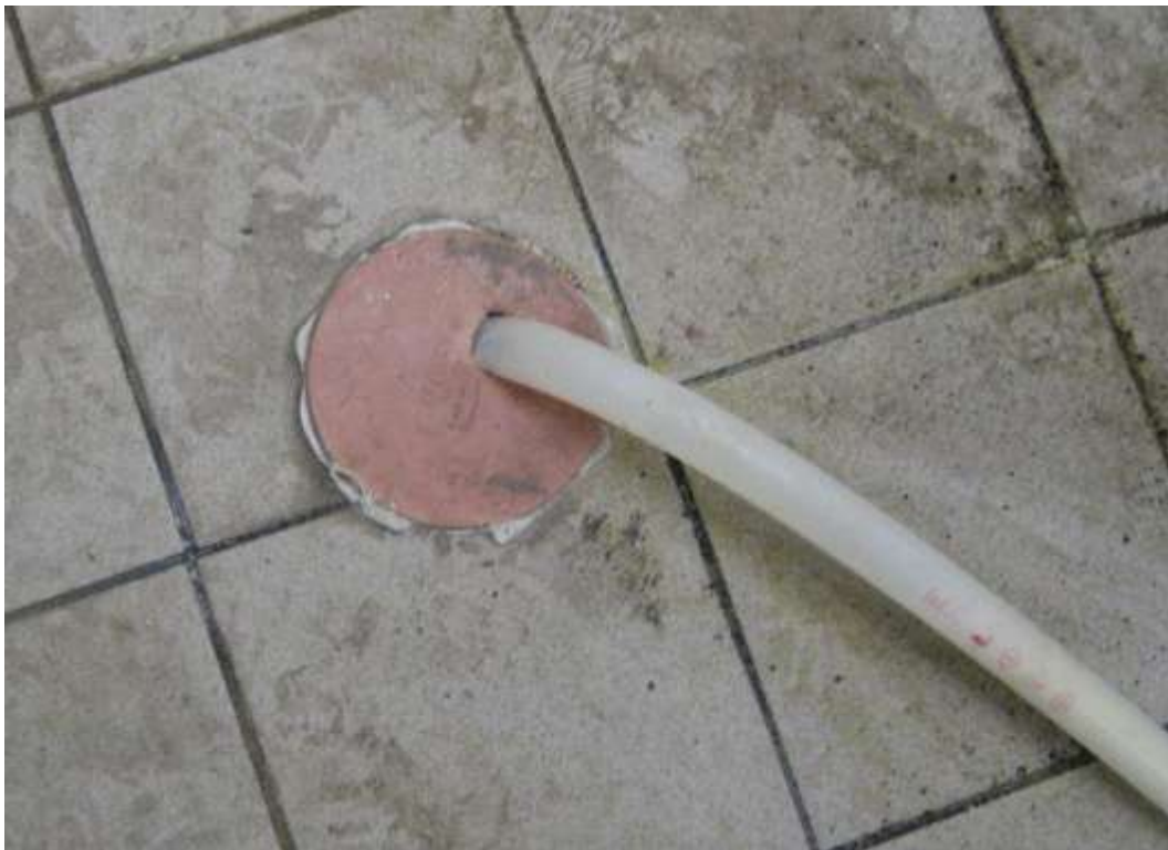
Skolvatn frá mjólkurtankavotti er stundum leitt niður á mjólkurhúsgólfid en ekki beint í niðurfall. Slíkt er algjör óþarfí og um að gera að koma vatninu strax í niðurfall eins og hér hafði verið gert.
