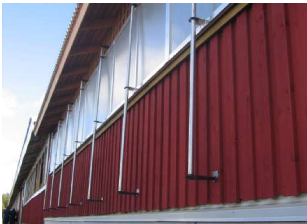
Á þessari mynd má sjá svolítið óhefðbundna lausn á veggopnun, en í þessu tilfelli rennur veggglugginn upp og niður í stað þess að opnast út og inn.
