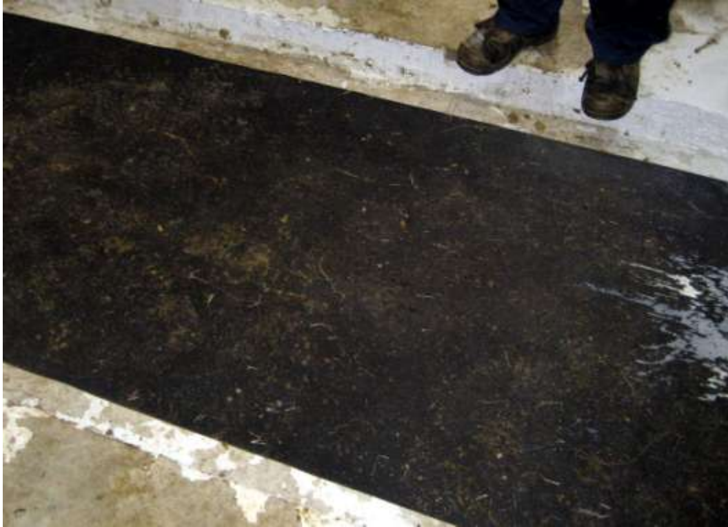
Þvergangur sem er niðurfelldur að hluta, um slíkar mishæðir geta sköfuróbótar ekki farið.
