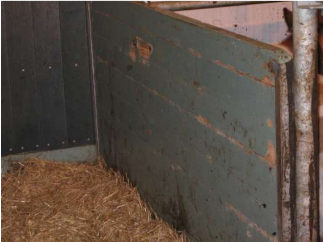
Þessi mynd var tekin í árgömlu fjósi og milliveggur úr timbri í kálfastú strax farinn að láta verulega á sjá.
