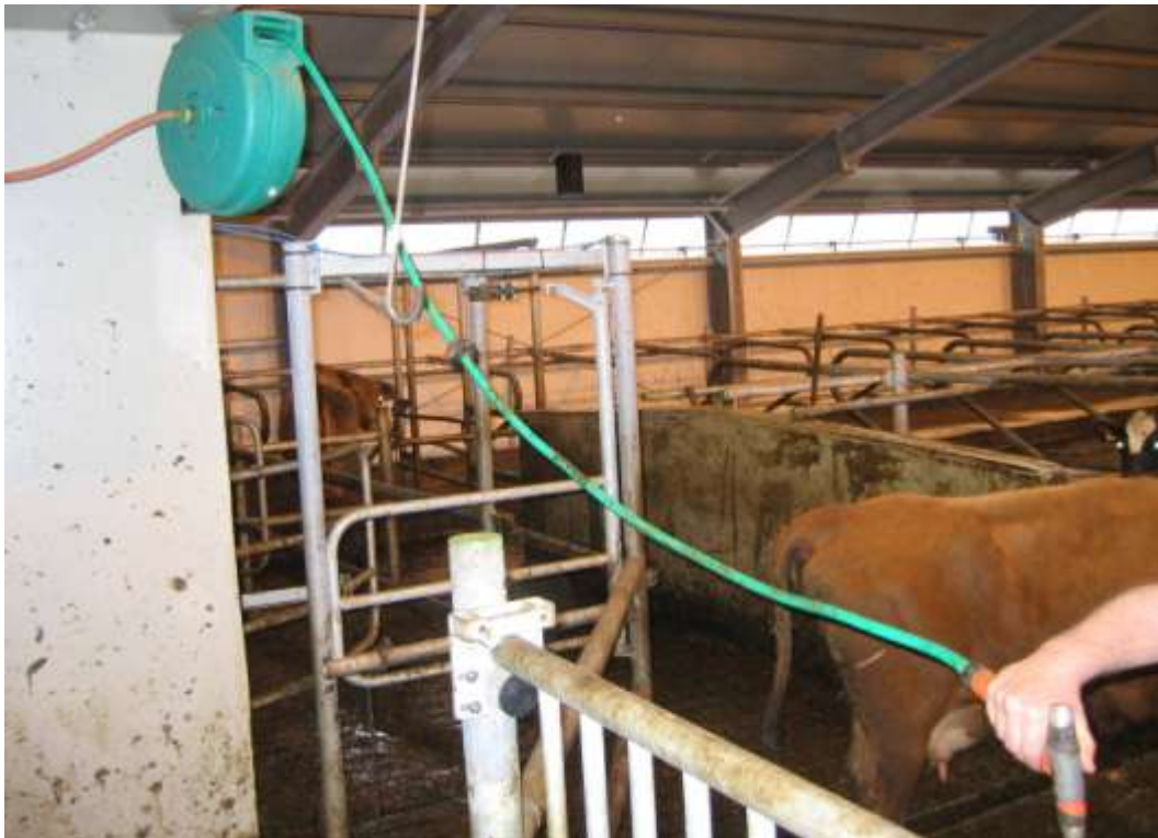
Þrif fjósa eru með brýnni verkefnum og þar sem mjaltþjónar eru þarf að vera með „kústinn á lofti“ oft á dag svo líf- og frumutölur haldist viðunnandi. Til þess að auðvelda þessa vinnu er um að gera að hafa aðgengi að vatnsslöngum sem víðast. Hér er einföld lausn.
