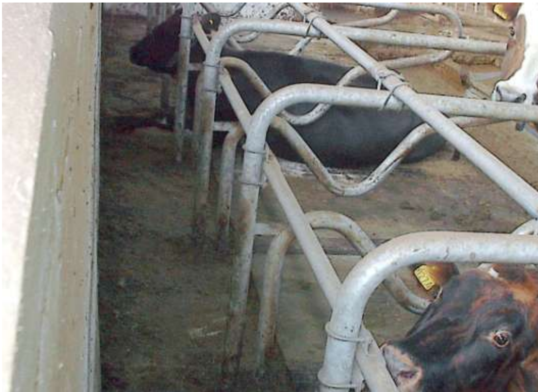
Hér nýtist framsvæði legubása sem eftirlitsgangur en er full þröngur svo hann þjóni vel hlutverki sínu.
