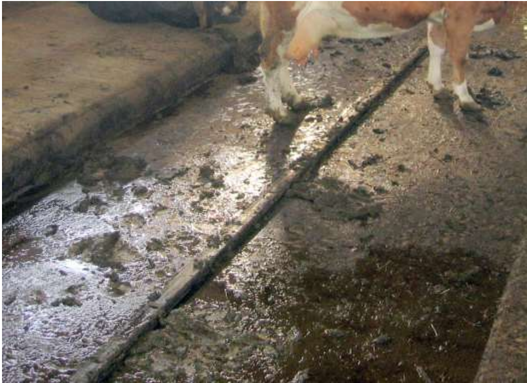
Afar víða var sköfuprófillinn ofan á sléttum flór, nokkuð sem ekki er ráðlagt að gera nú orðið.
