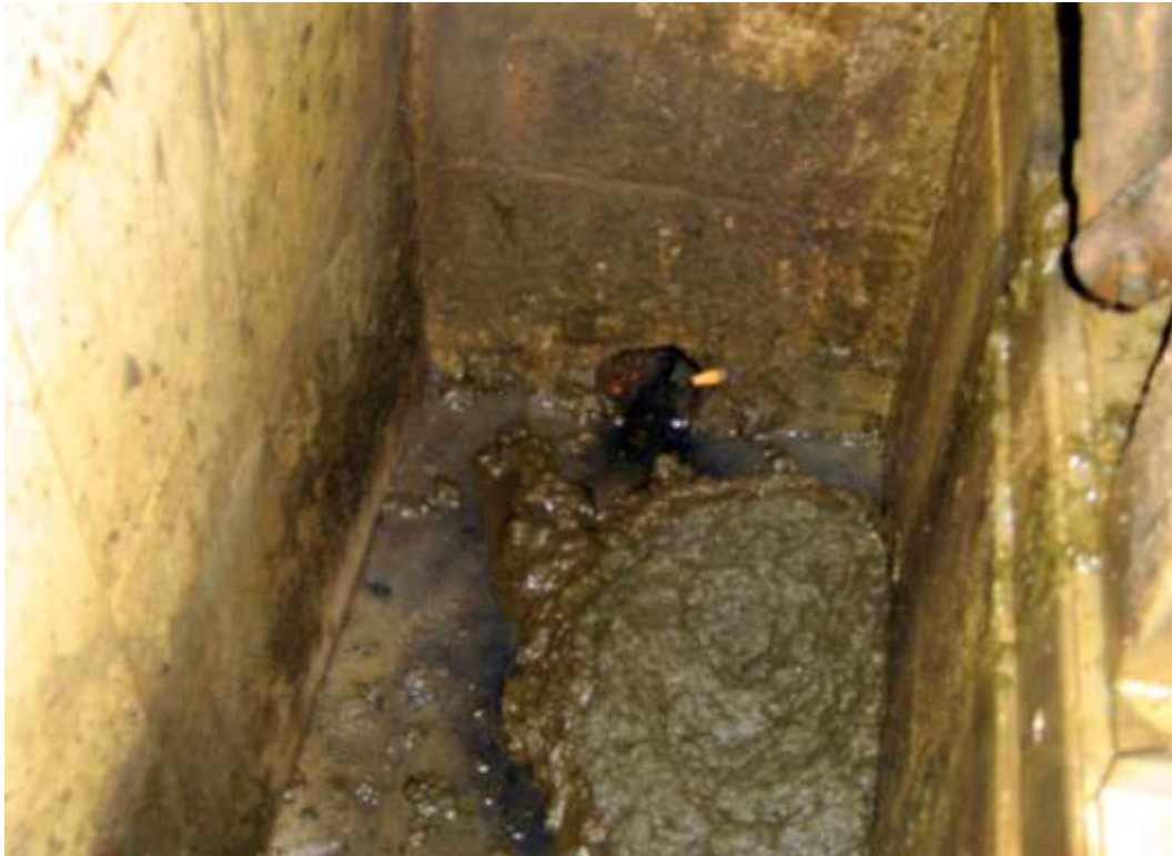
Hér er önnur leið sem hægt er að fara, setja gryfju við mykjurennu mjaltapjóns sem tengd er við haughús með 100 mm röri en reglulega þarf að skola gryfjuna.
