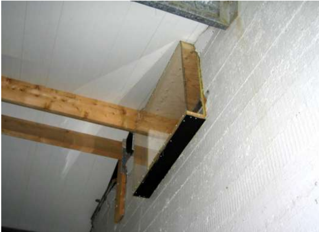
Þar sem rými á efri hæð er nýtt, er um að gera að setja glugga og hafa þá útstæða því þá sést betur yfir fjósið og til hliðanna.
