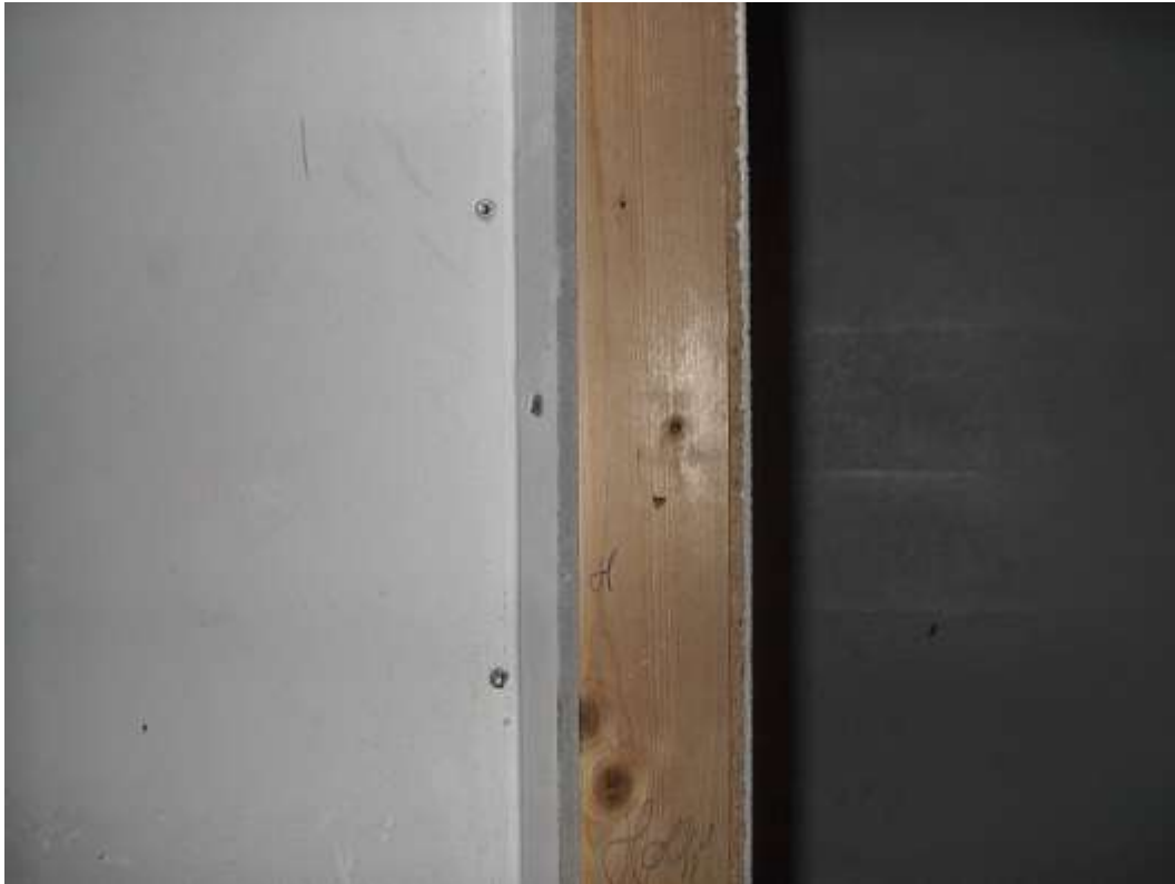
Hér er áhugavert efni, einskonar plast-krossviður, sem hefur verið skrúfaður utan á timburvegg í mjólkurhúsi.
