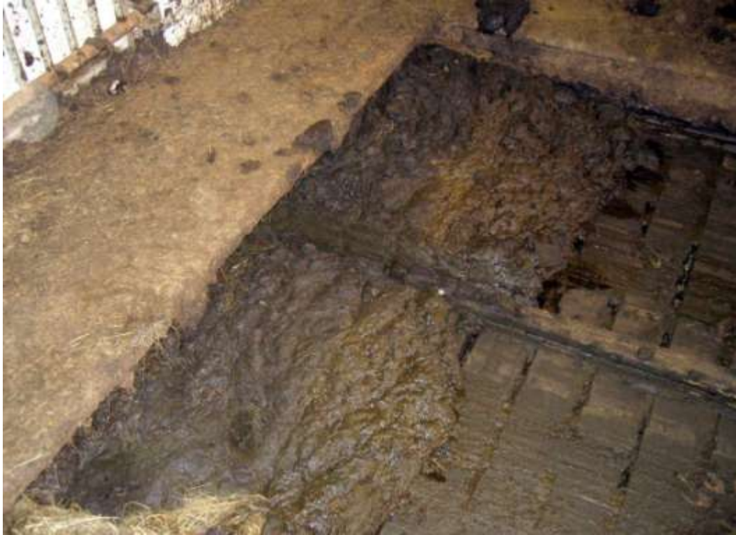
Hér sést ágætis hugmynd um sleppistað sköfukerfis, þ.e. hún ýtir skítum ofan í yfirbyggðan flór, en brautin ekki látin ganga nógu langt og því situr skítur ofan á rimlunum framan við.
