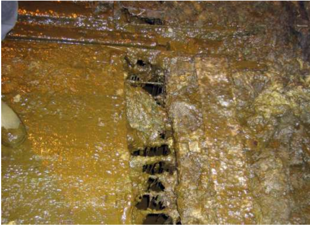
Hér var ágæt lausn við sleppisvæði sköfu, sk. fellihleri með kálfavörn. Heldur þétt er þó á milli pílára, 10 cm á milli er hæfilegt bil.
