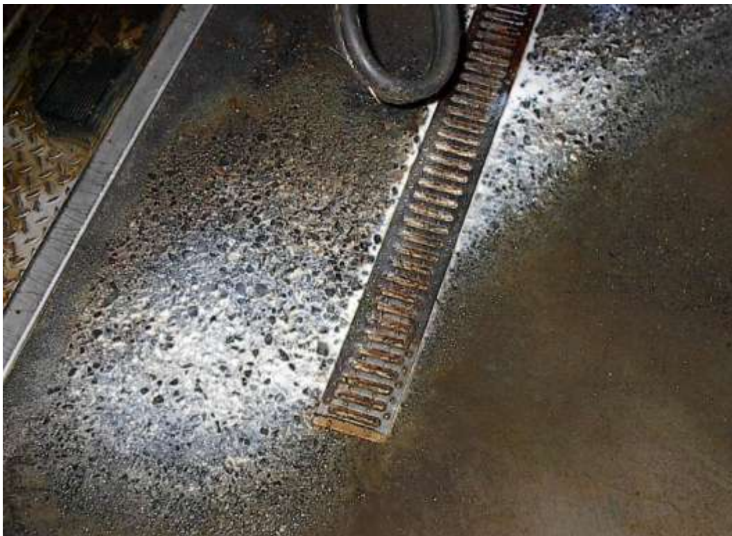
Langtímatæring á gólfi við mjaltþjón. Erfitt er að bregðast við eftir að starfsemi er hafin enda ganga mjaltþjónar allt árið um kring.
