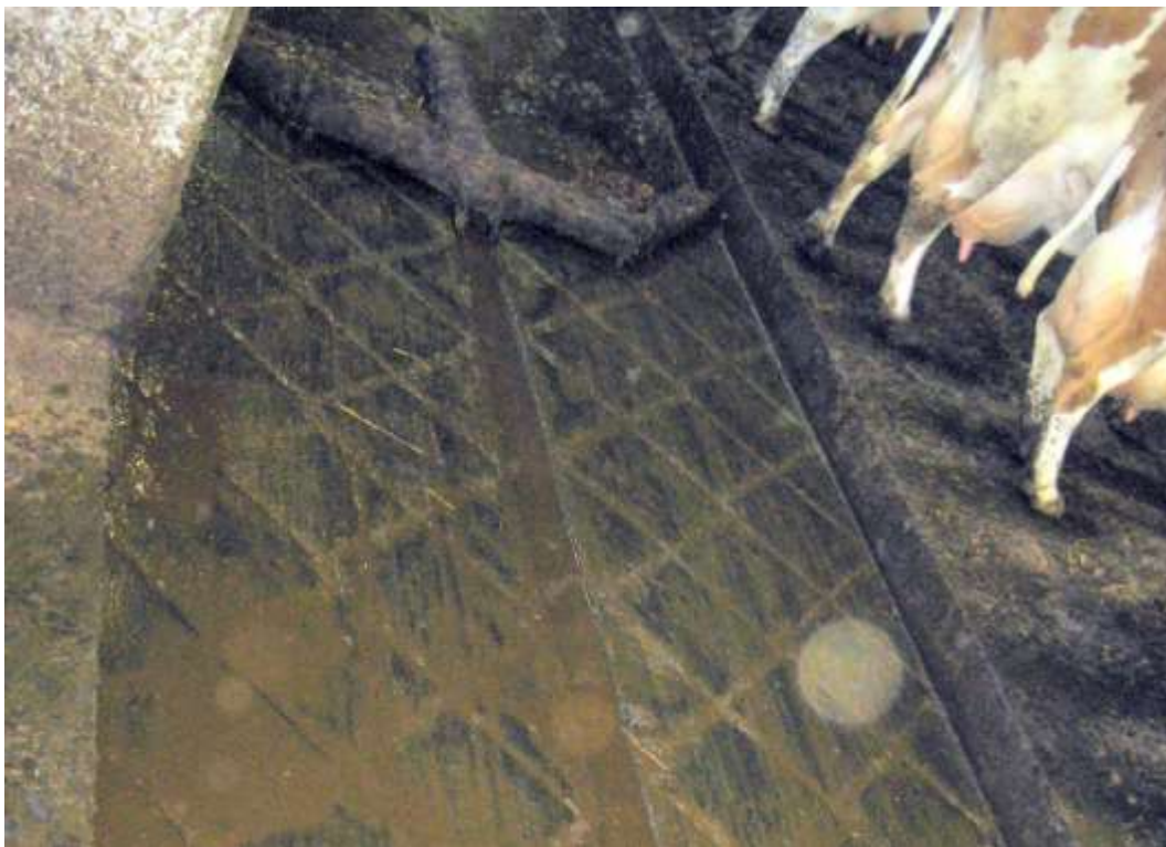
Munstur í steypu minnkar hálfu flóranna og er ekki svo erfitt að framkvæma sé rétt staðið að málum
