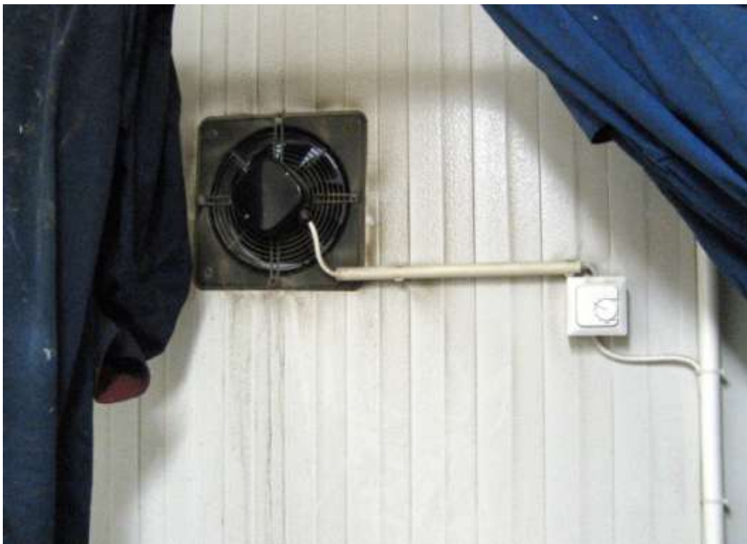
Afar einföld en góð lausn, vífta með hitaskynjara sá um að koma heitu loftinu út úr tækjarýminu eftir þörfum. Muna þarf að þar sem lofti er dælt út, þarf að hleypa öðru lofti inn annarsstaðar.
