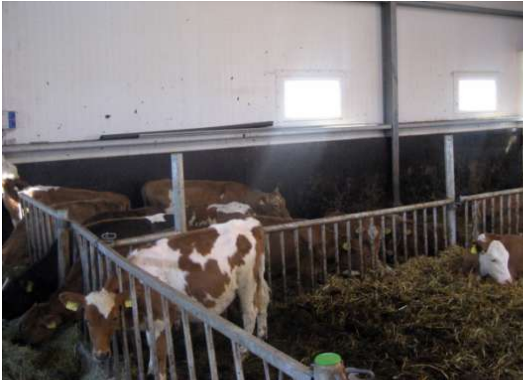
Í þessu fjósi var eina leiðin til þess að moka út að fjarlgæja jötugrindur og keyra vélar niður í stúrnar frá fôðurgangi með tilheyrandi sóðaskap. Auðvelt hefði verið að setja hurð á gafl fjóssins við byggingu þess.
