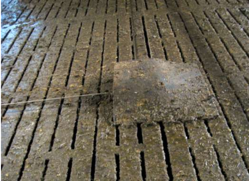
Snyrtilegur frágangur á trissuhjólí sköfukerfis, sem hentar þungstígum kúm vel.
