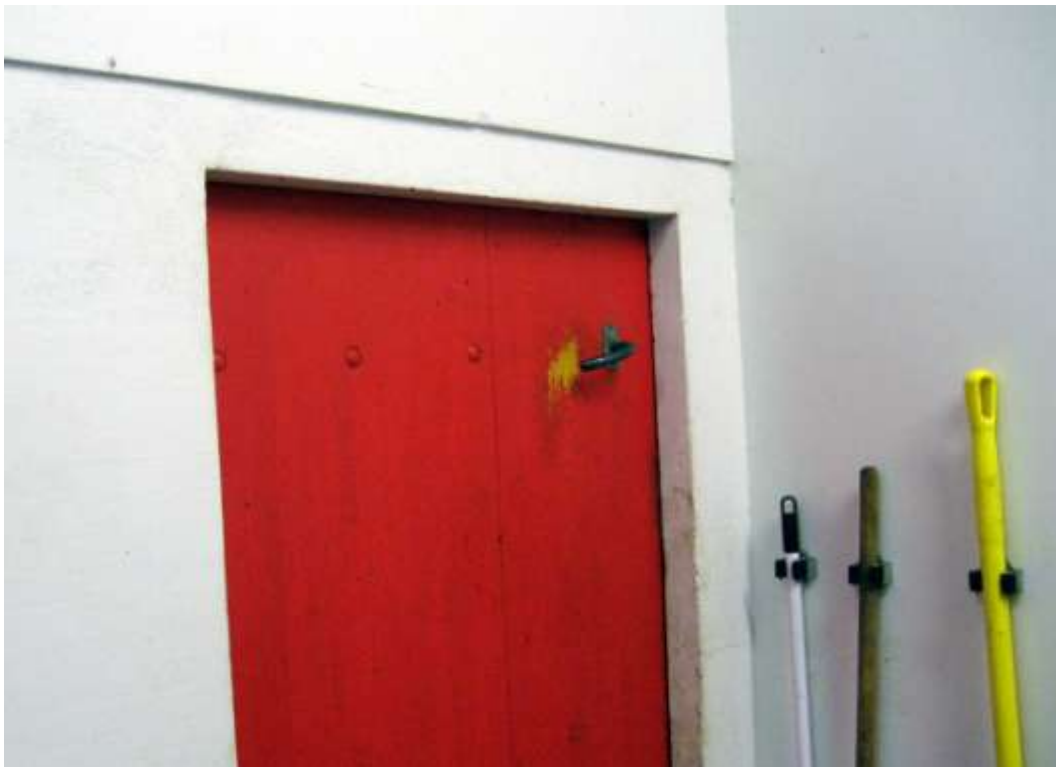
Til þess að útiloka að kálfar fíkti í hurðarhúni og opni þannig óvart, var hann staðsettur efst á hurðinni.
