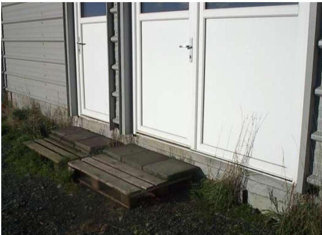
Trúlega einna algengasta „lausnin“ þegar komið er að nýjum og/eða nýlegum fjósum. Pallettur nýttar sem tröppur við inngang.
