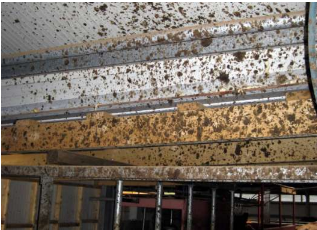
Versta dæmið um afleiðingar slettugangs frá klafum kúa sem „smella“ út af sköfuprófil sem er ofan á flór.
