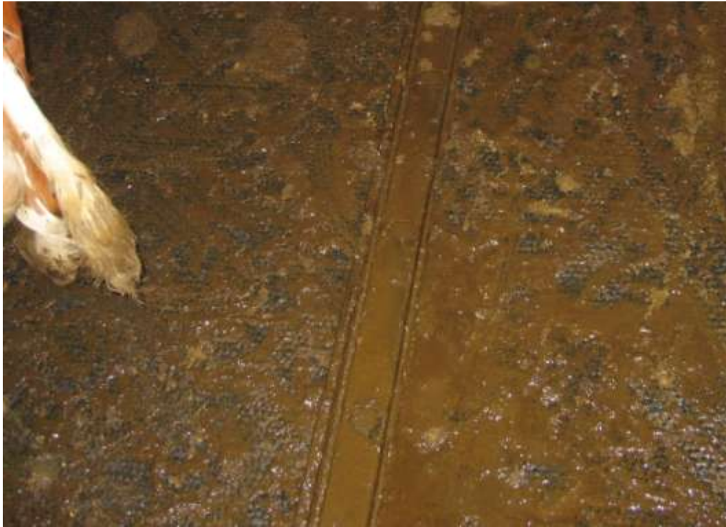
Vel frágenginn sköfuprófíll, niðurfelldur
