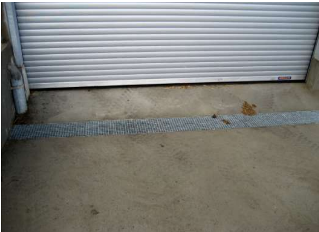
Við margar innkeyrsluhurðir vantar einnig niðurföll og margir bændur ósáttir við það eftirá. Hér sést góð og mikil rist sem óhætt er að mæla með að bændur fái sér við allar stærri hurðir.
