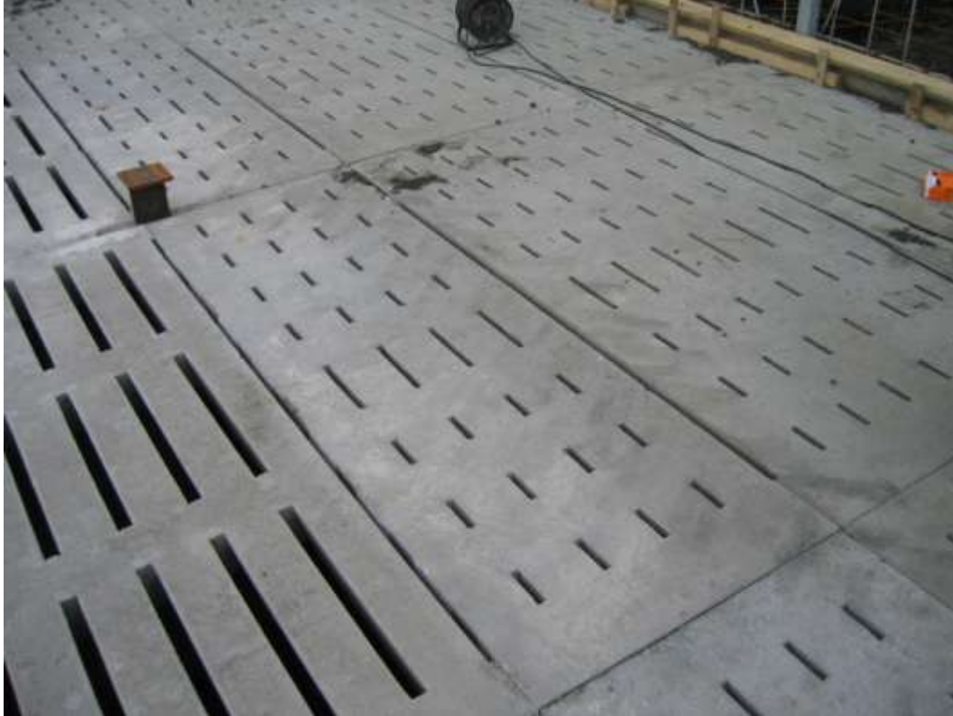
Hér má sjá forsteyptar einingar sem mynda botn í hálmstíu.
