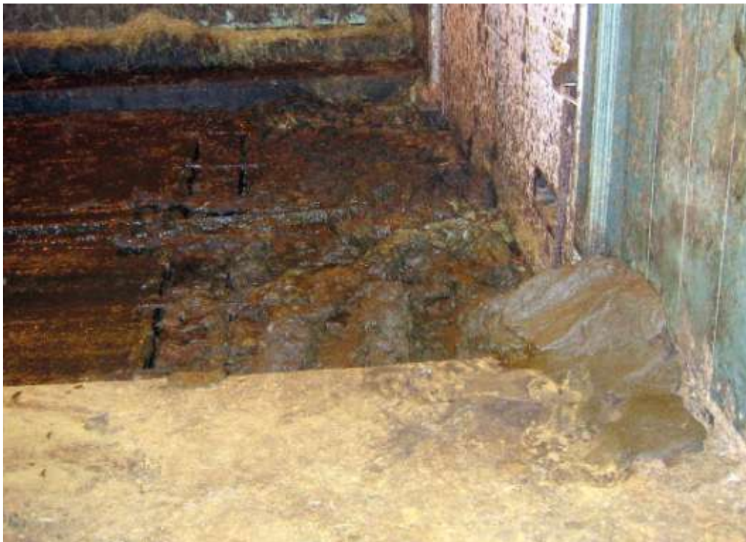
Ennfremur reyndist afar algengt að svæðið sem sköfurnar skila af sér er of stutt eða illa frágengið. Hér var sk. sköfudreki fyrir framan og sleppisvæði sköfunnar því nærri 1 metra frá vegg.
