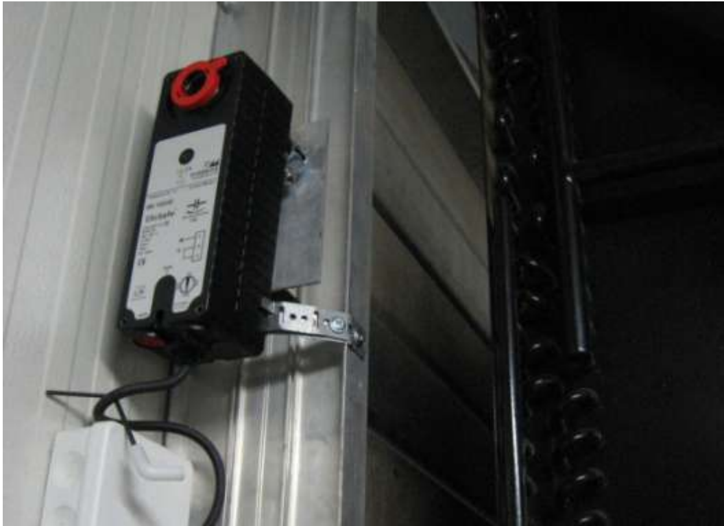
Innandyra var spjaldmótor sem stýrði því hvort öndunin við kæliverk kælipressu mjólkurtanksins væri opin eða ekki.
