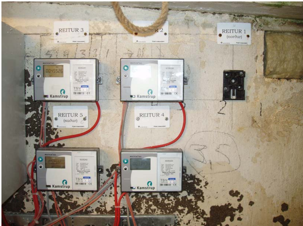
16. mynd. Mælar sem sýna vatnsnotkun einstakra reita.
