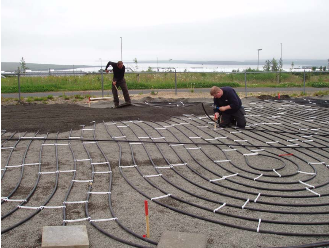
3. mynd. Lögnin hulin með efra millilaginu.
