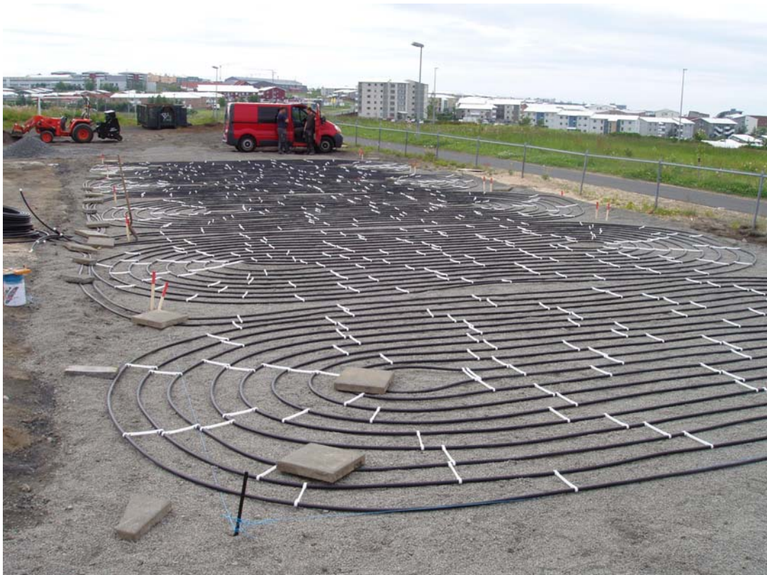
2. mynd. Hitalögn komin á sinn stað.
