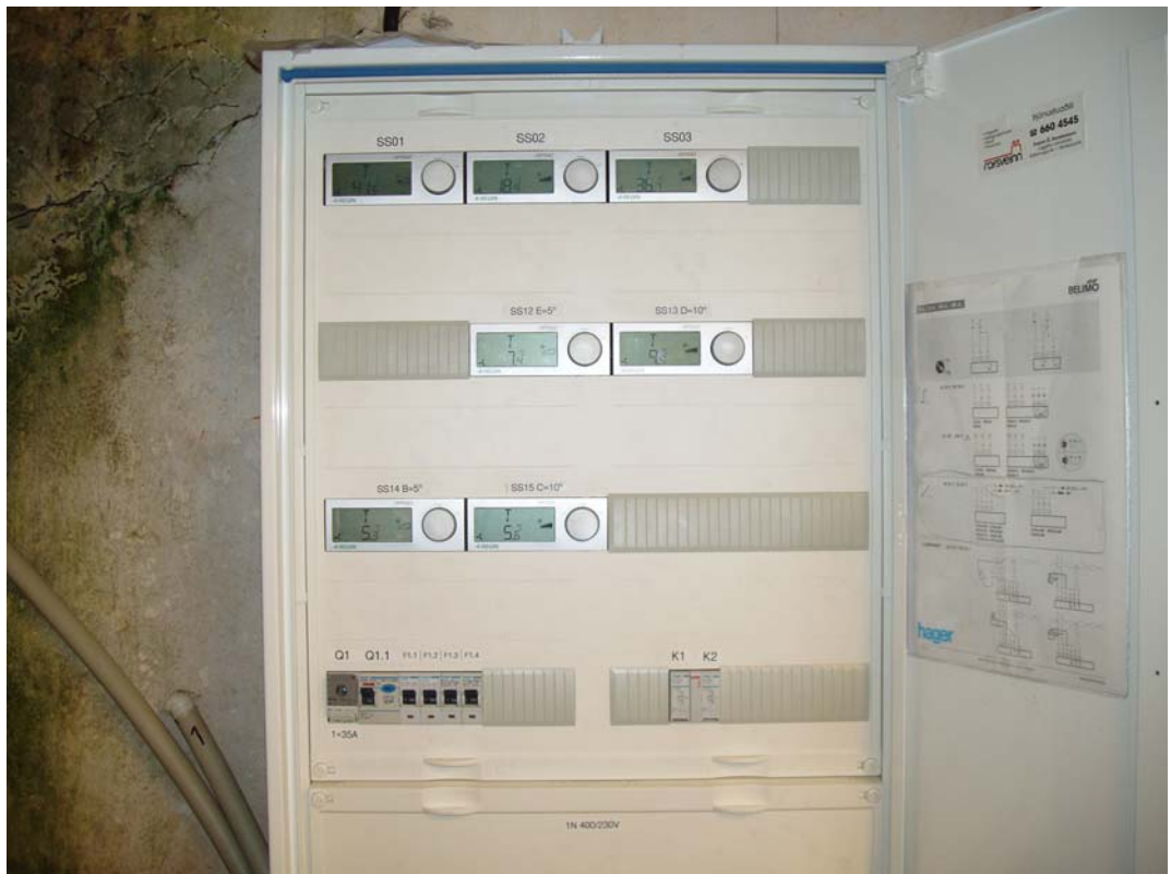
15. mynd. Skápur með hitamælum og hitastillum.
